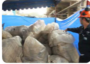
แยกแผ่นใยแก้ว insulation ออกจาก cladding เพื่อป้องกันถูกฉีกขาด
